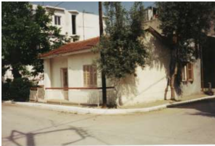
Αυτά είναι τα πραγματικά σπίτια και τα μόνα που διατηρήθηκαν μέχρι τι 1994 They are the real houses survived from demolition until I was there in 1994
