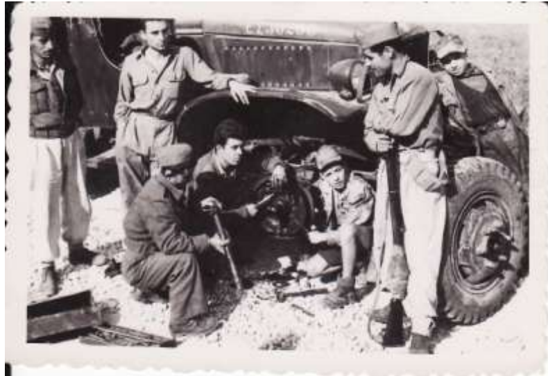
Αχλαδοχώρι 1952 . Εδώ βγάλαμε τον μπροστινό τροχό για ν' αλλάξουμε το μπροστινό άξονα και τα ρουλεμάν από ένα GMC του λόχου μεταφορών.
