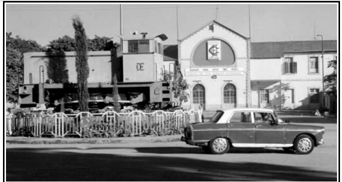
Ο σιδηροδρομικός σταθμός
